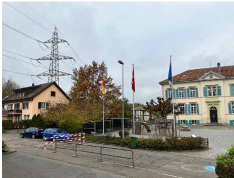
Die betroffene Hochspannungsleitung führt über Schulen, Wohnquartiere und Fabriken. (Bild: Reni Bircher)
