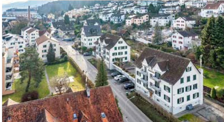
Die 100 Jahre sieht man der Liegenschaft nicht an: Etzelstrasse 54/56.
