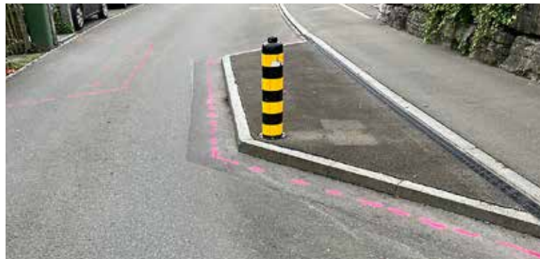
Teilweise werden Schutzräume für Fussgänger versetzt.
