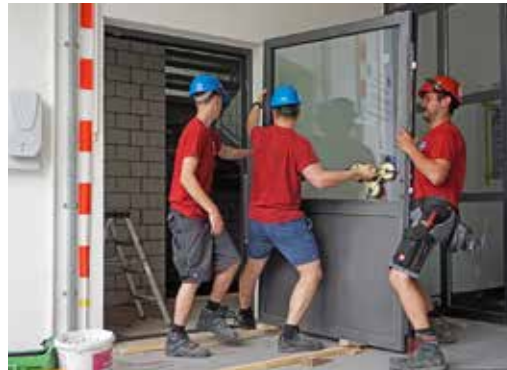
Türen werden aus- und dereinst in Samstagern wieder eingebaut.
