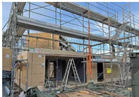
Das neue Haus ist am Entstehen.
