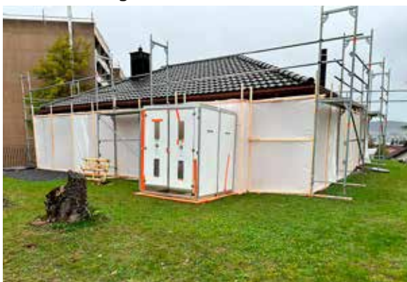
Asbestsanierung vor dem Abriss.
