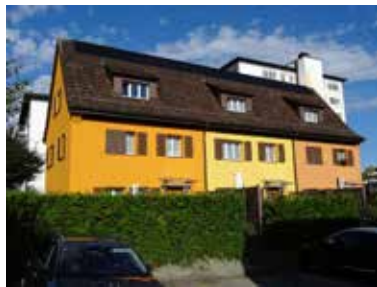
Zugerstrasse 92-96 (6,8 kWp): Produktion von 69% des Jahresverbrauches.
