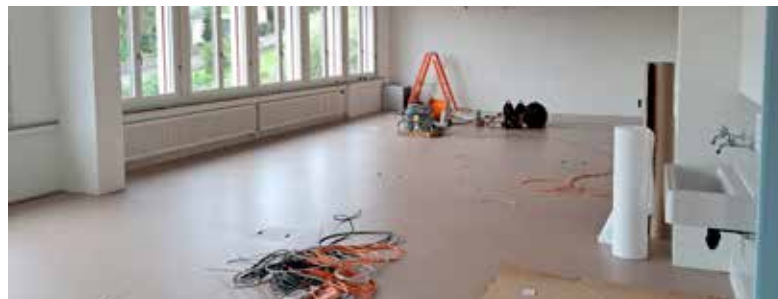
Im Westtrakt wird an den neuen Räumen für die Sportklasse gebaut.
