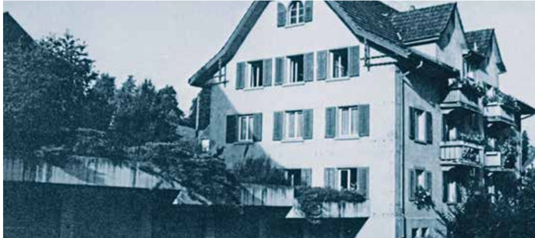
Die erste Liegenschaft der MBG an der Etzelstrasse bietet auch heute noch günstigen Wohnraum.
