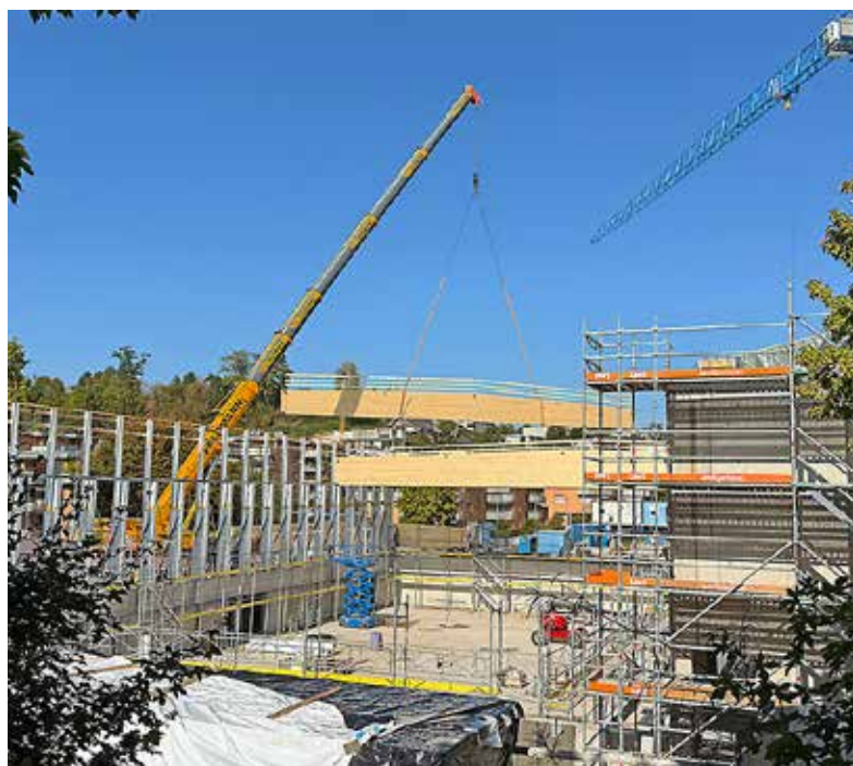
Der 12,5 Tonnen schwere Binder wird vom Kranführer ruhig und gezielt zum Bestimmungsort gehoben. (Bild: Reni Bircher)
