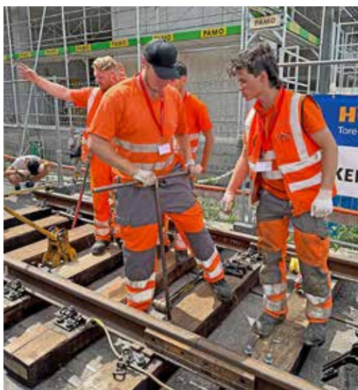
Vorführung beim Gleisbau.
