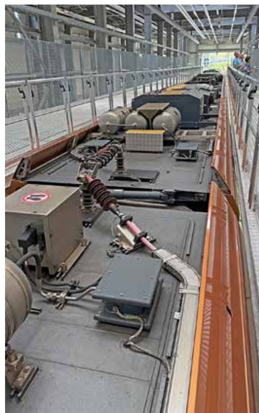
Blick auf den Traverso von der Dacharbeitsbühne.
