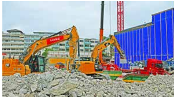
Schwere Baumaschinen prägen das Bild: Ein Blick hinter die Kulissen der Grossbaustelle während der Führung.
