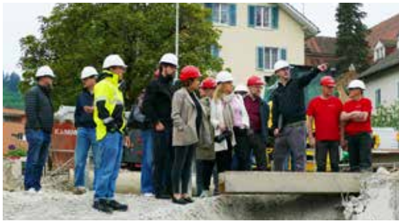
Mit grossem Interesse informierten sich die Teilnehmerinnen und Teilnehmer der Führung über den aktuellen Stand der Baustelle.
